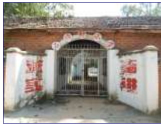
灘湖壩近くの廟跡
